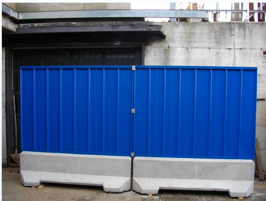
La recinzione mobile tipo CA.MET è realizzata con pannelli modulari di altezza pari a 1,5 metri installati su basamenti in calcestruzzo da interasse mt. 2 con altezza di 55 cm circa. Ciascun pannello è costruito da un pannello cieco di lamiera grecata colore blu e grigio.
